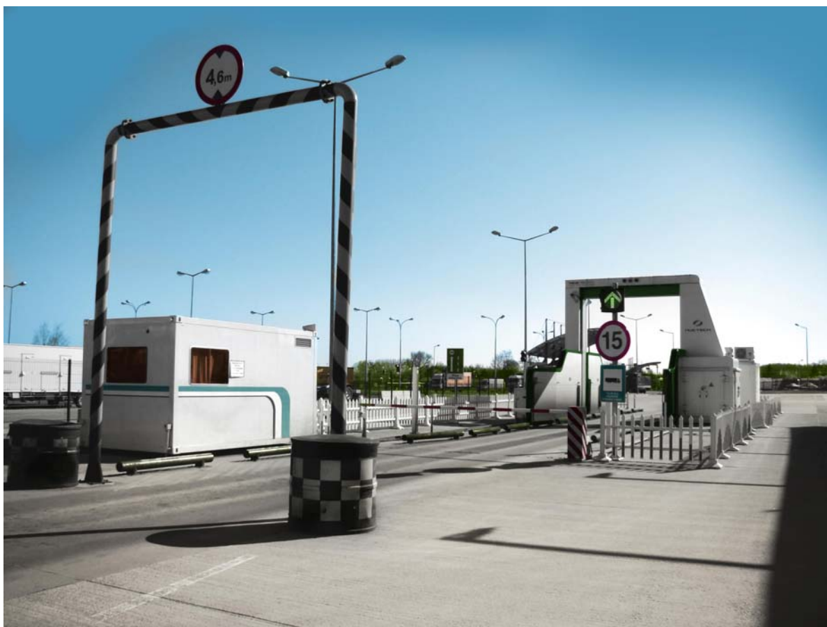
Rysunek 2. Skaner stacyjny do rentgenowskiego skanowania pojazdów.
